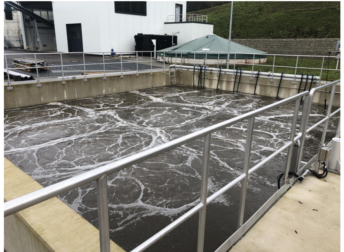
Beispiel: Abwasserreinigung System Biocos®
