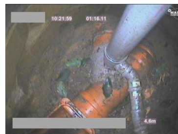
Dachentwässerung (HT) an SW (KG)
