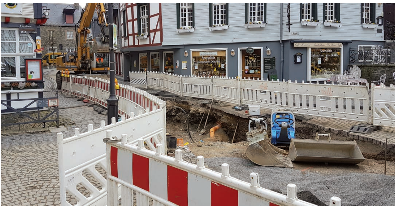
Baustellenabschnitt in der Monschauer Innenstadt (Austraße/Markt)
