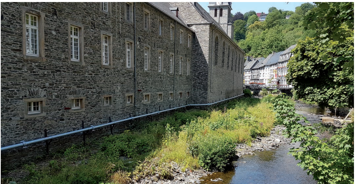
Rur am Aukloster mit provisorischer Wasserhaltung
