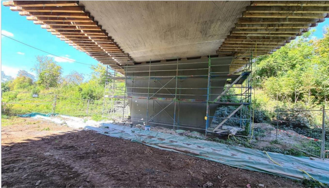
Der Brückenpfeiler, der wegen des Eindringens von Wasser in den Beton unter einer Chloridvergiftung litt, ist wieder vollständig hergestellt. Foto: MHA/Thomas Vogel
