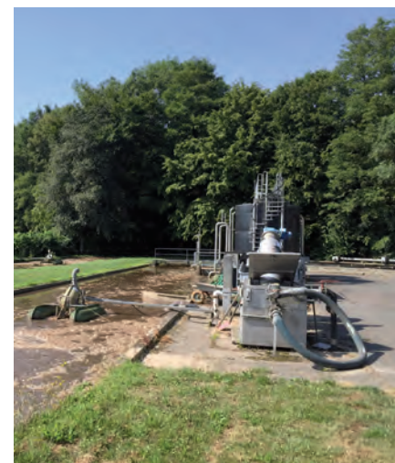
Oben: Alte Kläranlage Mettendorf in Betrieb
