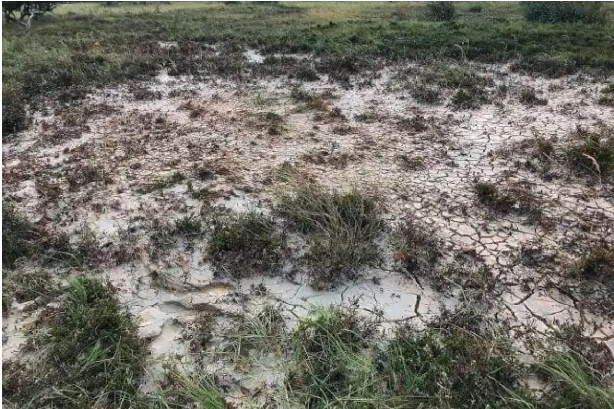
Abb. 1: Spülsausruch in kiesig-sandigem Baugrund
