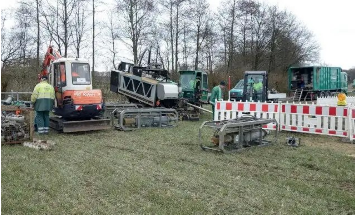
Abb. 7: Baustelleneinrichtung für den Feldversuch
