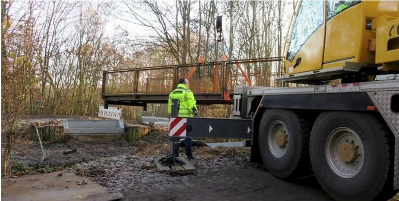
Ein 60-Tonnen-Kran setzt die neue Brücke in die zuvor hergerichteten Fassungen. Diese werden anschließend noch mit Mörtel aufgefüllt.
