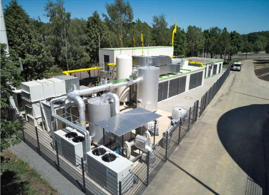
PSA-Gasaufbereitungsanlage der Biogaspartner Bitburg GmbH mit einer Rohgaskapazität von 1.800 Nm<sup>3</sup>/h.
