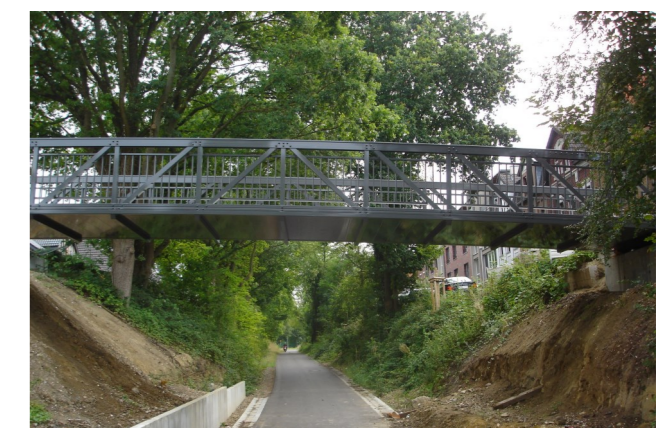
Fußgängerbrücke Euchener Straße
