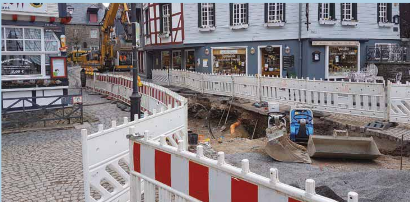
Baustellenabschnitt in der Monschauer Innenstadt
