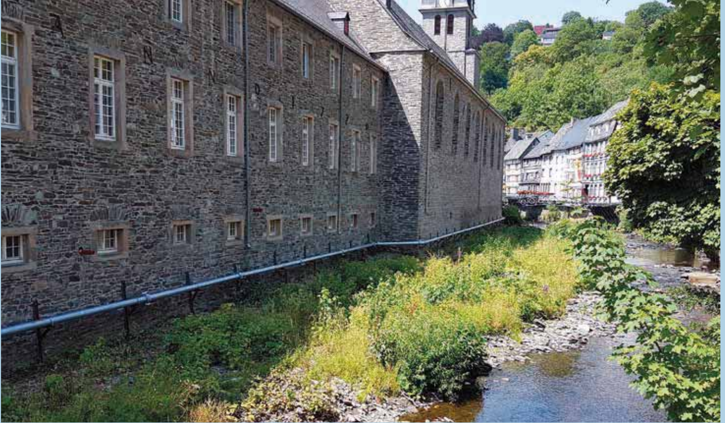
Rur am Aukloster mit provisorischer Wasserhaltung
