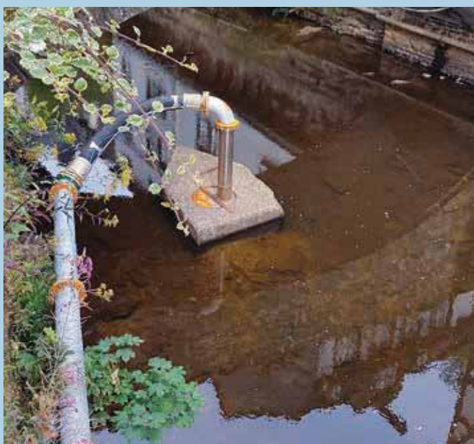
Entnahmeschacht für die Wasserhaltung im Gewässer
