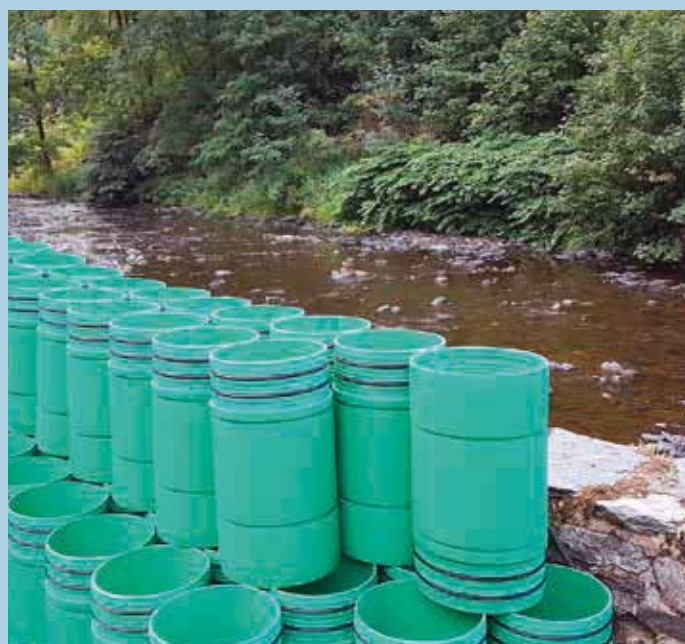
PP-HM-Kurzrohre vor dem Einbau
