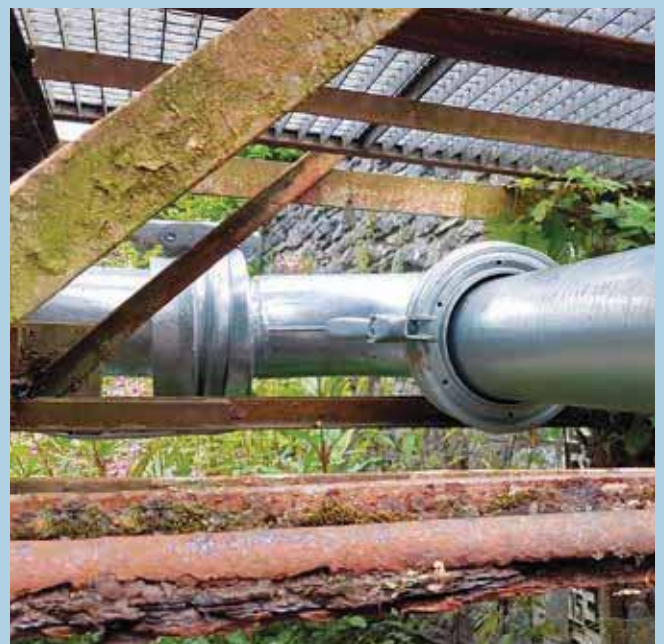
Druckleitung DN 200, Wasserhaltung
