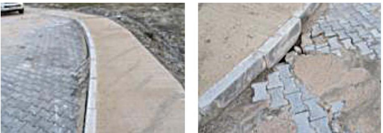
Insgesamt wurden die Arbeiten zur Herstellung der Infrastruktur sehr mangelhaft durchgeführt, so dass schon vor Inbetriebnahme deutliche bauliche Schäden auch an den Straßenflächen festzustellen sind.
