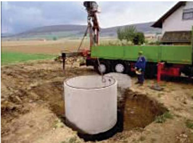
Abb. 18: monolithischer Sammelbehälter aus Fertigbeton / Mall 2011 /
