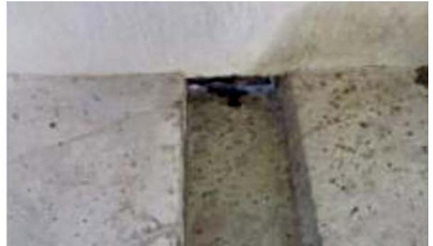
Durch eine Verrohrung unter dem angrenzenden Weg gelangt die Gülle direkt in den Uferbereich des Tersakan und anschließend in die fließende Welle.
