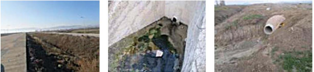
In den Straßen wurde eine Regenwasserkanalisation verlegt, die auch in den vorhandenen Entwässerungsgraben mündet. Weiterhin führt eine abgedeckte Betonkastenrinne zum Graben. Diese Kastenrinne ist zwischen den Straßen über alle Parzellen verlegt.
