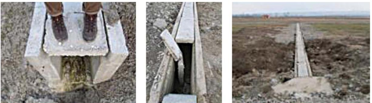
Kurz nach Fertigstellung befindet sich die Kastenrinne schon in einem baulich völlig desolaten Zustand (siehe Fotos). Zudem weist sie ein unzureichendes Gefälle auf, da sie einfach bündig zum Gelände eingebaut wurde.
