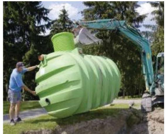
Abb. 19: monolithischer Sammelbehälter aus Kunststoff / Mall 2011 /
